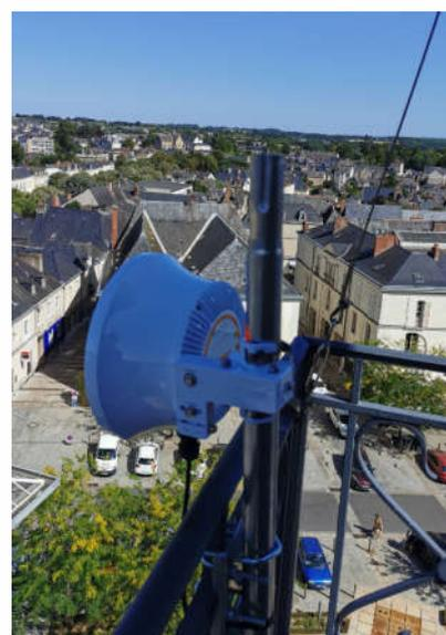
Exemple d'installation d'un pont MIMOSA B24
