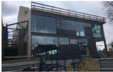
La nouvelle médiathèque pendant sa construction en février 2018
