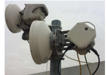
Pont FH Eaubonne
