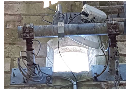
Pont FH installé à l'Eglise Sainte Europe
