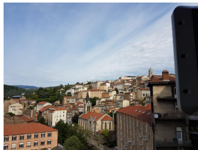
Pont radio INFINET sur un bâtiment à d'ANNONAY
