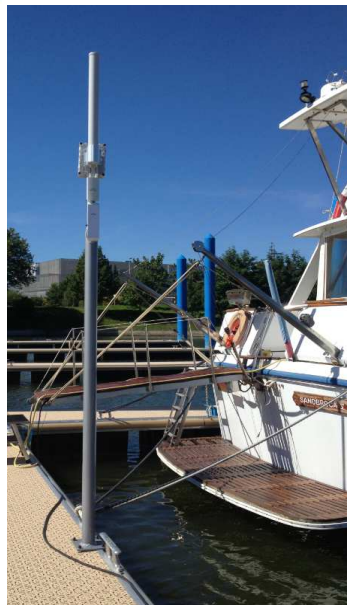
Antenne WiFi au port de Mâcon
