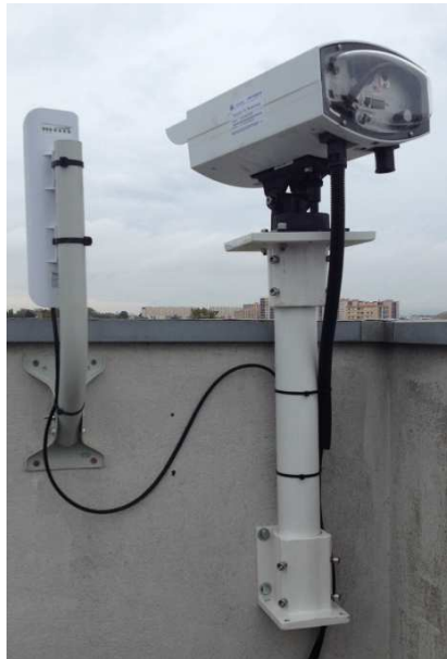
Têtes laser LIGHPOINTE avec secours radio UBIQUITI
